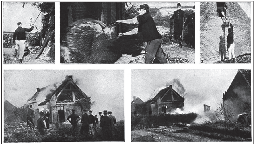
Het platbranden van de gebouwen in de zone van krijgsveldbaarheid. Alle brandbare gedeelten werden met brandstof overgoten, het vuur smeulde soms dagenlang. Opgevoerde werklieden moesten achteraf de muren slechten en de stenen kuisen en sorteren. (Verzameling Jos Bogaerts)
