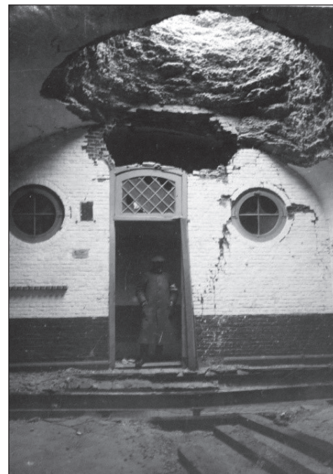
Het verschil tussen de uitwerking van een 30.5 cm mortier in Breendonck en dat van een 42 cm te Kessel (© Museum van het Leger en de Krijgsgeschiedenis)
