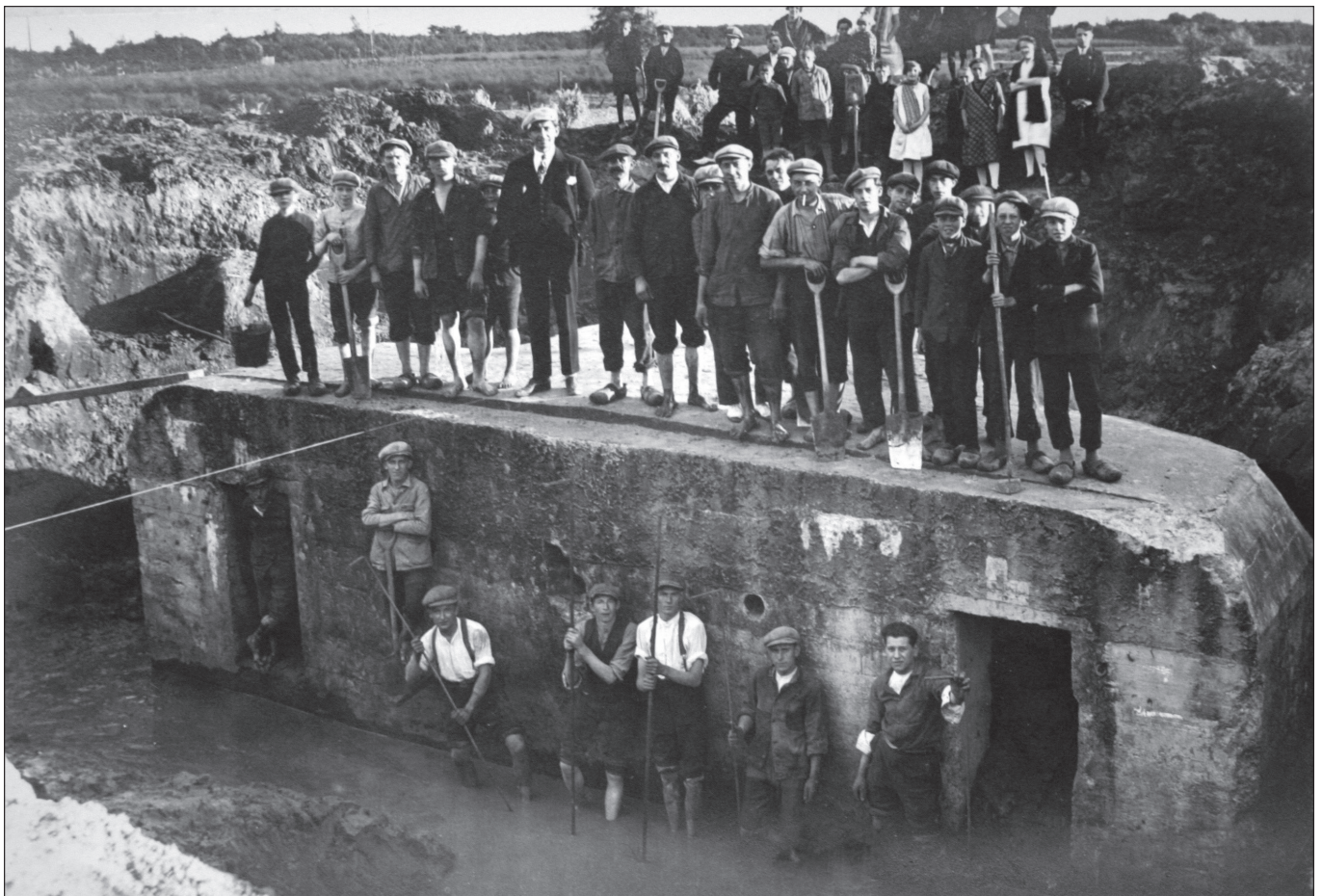
Bunker 5 uit de zone 1 stond na de oorlog in de weg voor de aanleg van het voetbalveld van Vlуг en Vrij. Onder leiding van Walter De Maeyer werd de bunker ondergraven en ondersteut met dennestammen. Eens volledig ondersteut werden deze ingestreken met brandstof en aangestoken. Even later donderde het gevaarte naar beneden, waar hij nog steeds, nu onder het korfbalveld, ligt. (Archief Walter De Maeyer)
