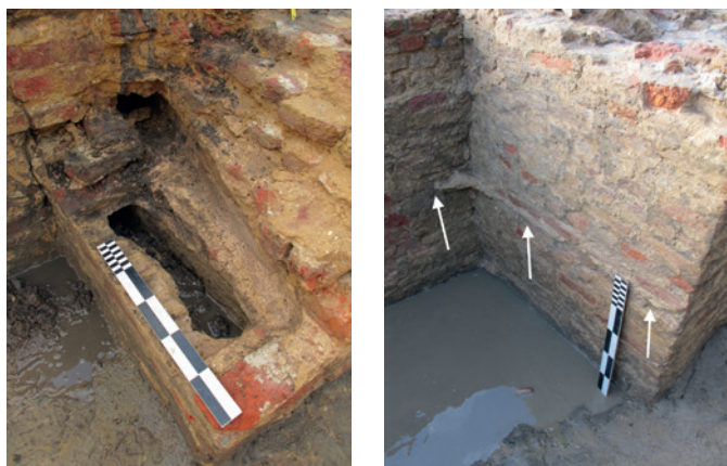
Figuur 5a en b: (a) restanten van ingemetselde houten balken, (b) een horizontale bouwnaad in één van de steunberen. De bouwnaad is aangeduid met witte pijlen (foto's P. Van den Hove)
