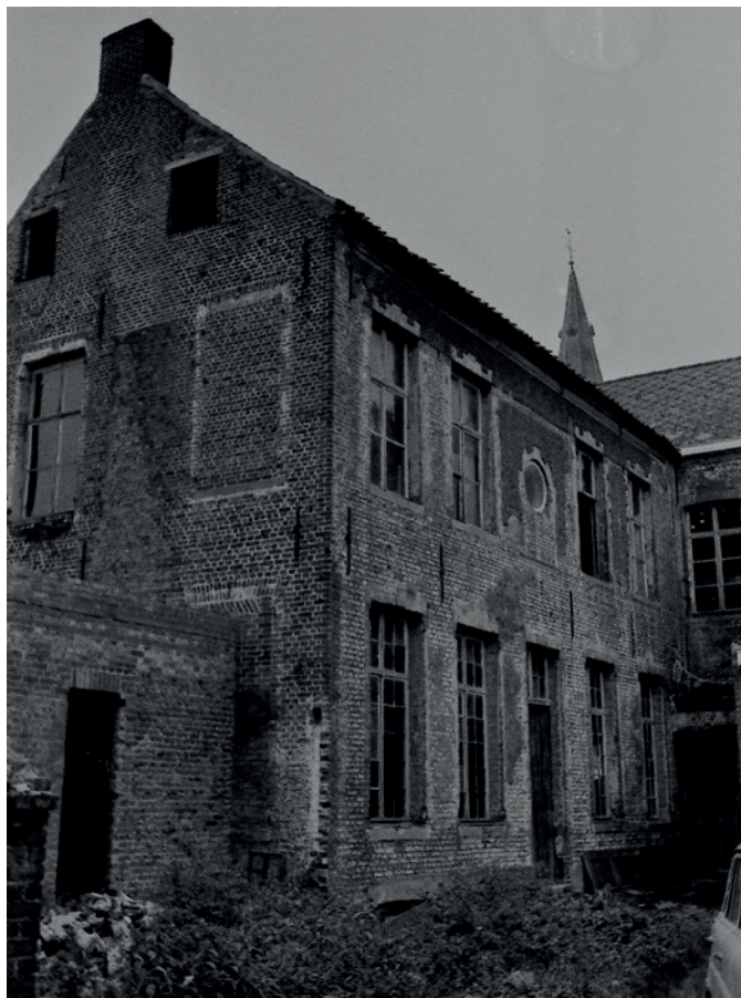
2 ramen onder en boven dichtgemetseld; 2 ramen op zolderhoogte later aangebracht.
