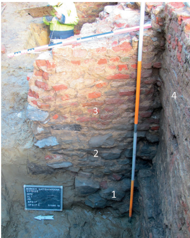
Figuur 10: vier bouwfasen in één van de bakstenen steunberen (foto P. Van den Hove)
