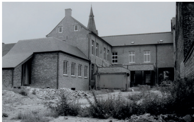
Bijvoegen van keuken voor hotel-restaurant en gelagzaal in de hoek van het oorspronkelijke gebouw
