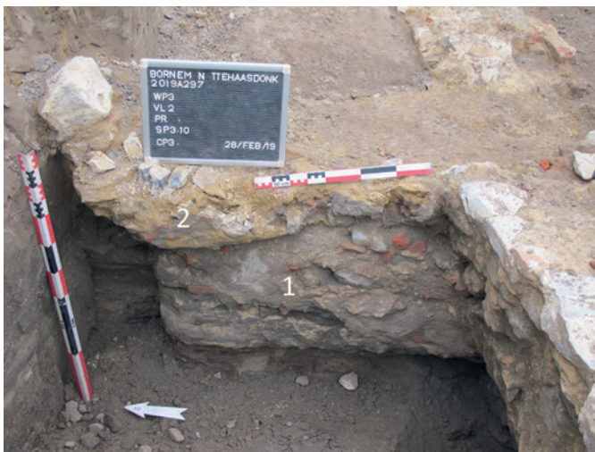
Figuur 9: twee bouwfasen zichtbaar in één van de bewaard gebleven steunberen in natuursteen (foto P. Van den Hove)
