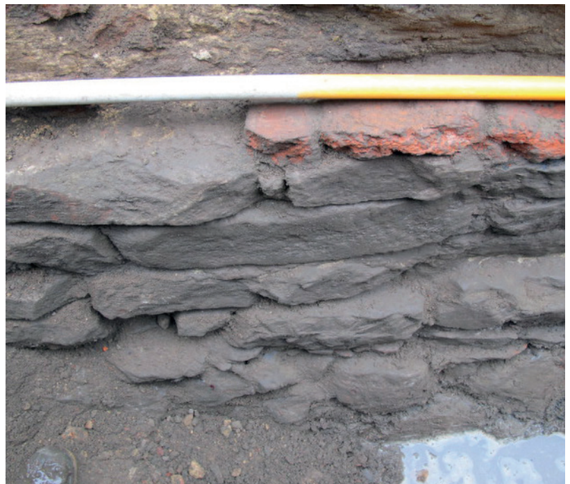
Figuur 8: details van het oudste muurwerk met een kern opgebouwd uit veldsteen, Romeinse dakpanfragmenten en een parement in Doornikse kalksteen (foto's P. Van den Hove)
