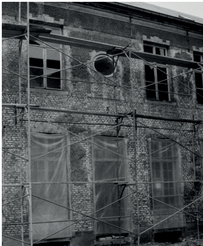
Ovaal raam of oculus is later aangebracht, want er zit een dorpel onder
