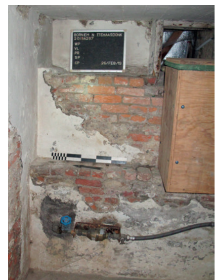
Figuur 4: de oostelijke bakstenen omheiningmuur is nog aanwezig in de kelder van huisnummer 5 Nattenhaasdonk (foto P. Van den Hove)
