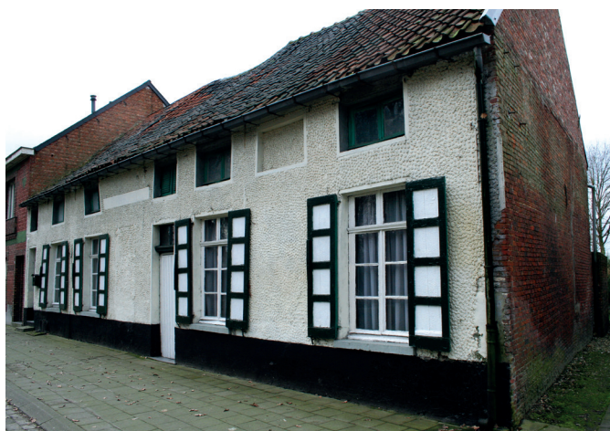
Zicht op de intussen afgebroken woningen A501e en A501d langs de Edmond Vleminckxstraat met rechts de kerkwegel (©J. Winckelmans)
