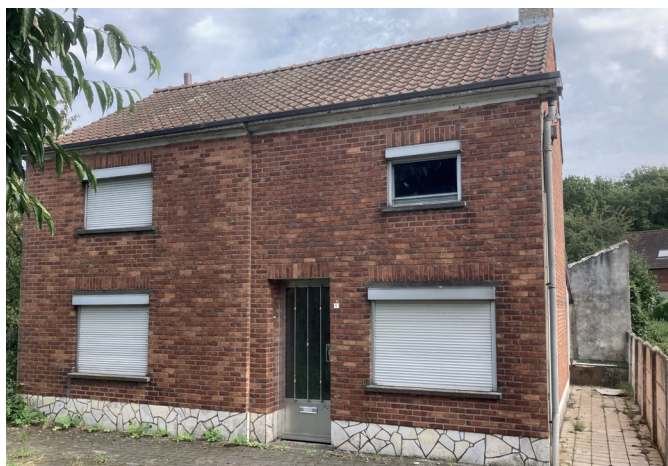
De woning A517c in de Schuttershofweg op het zuidwestelijke perceel van de 'Landuytes'-site
