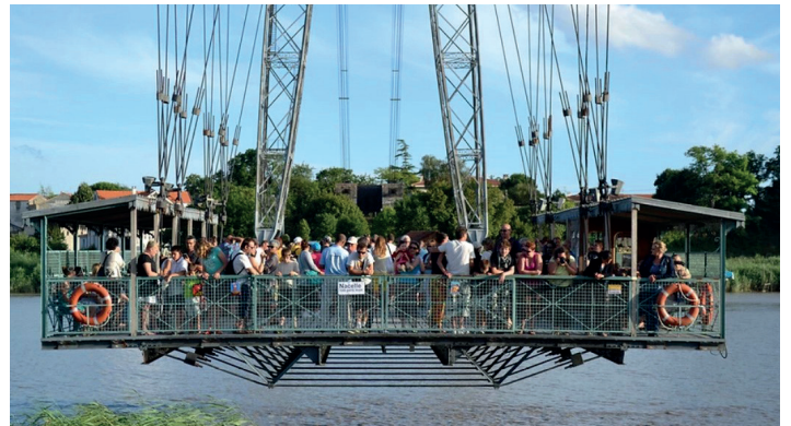
De transbordeur in Rochefort als voorbeeld
