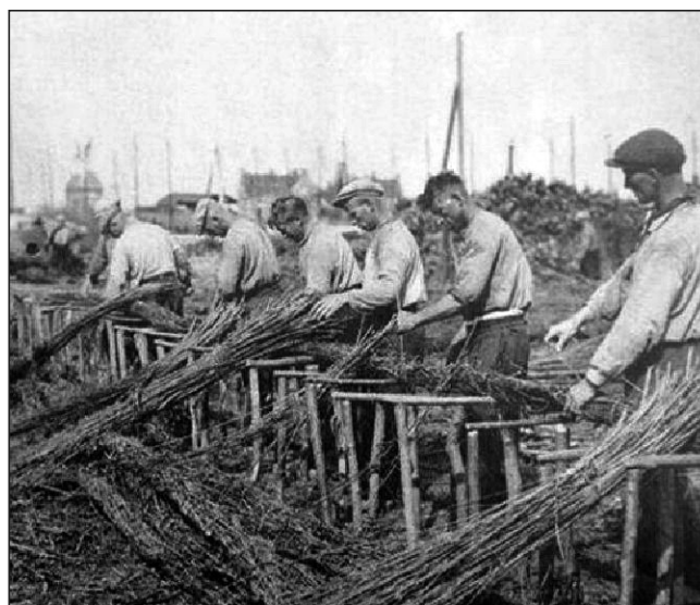
Afb. 26: Arbeiders aan het werk met rijshout. Inpoldering van het IJsselmeer 1937.
